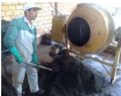
Figura 8 – Mistura com ajuda de uma betoneira dos componentes que faz o substrato.
